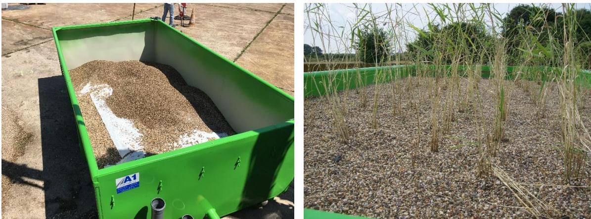
Abbildung 3-10: Bodenfilter im Bau (links) und nach Bepflanzung (rechts)
