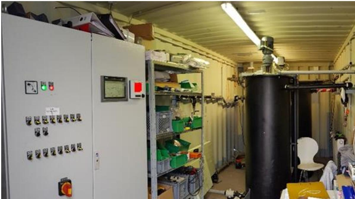
**Abbildung 3-6: Iso-Container mit Schalt- und Steueranlage sowie den beiden MBBR-Becken**
