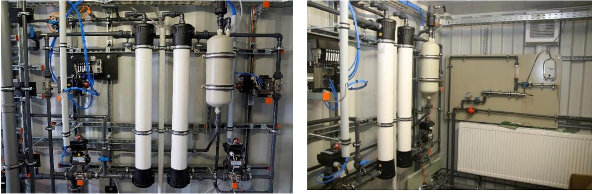
**Abbildung 3-12: Ansicht der UF-Anlage. Im rechten Bild ist im Hintergrund die UV-Anlage zu sehen**
