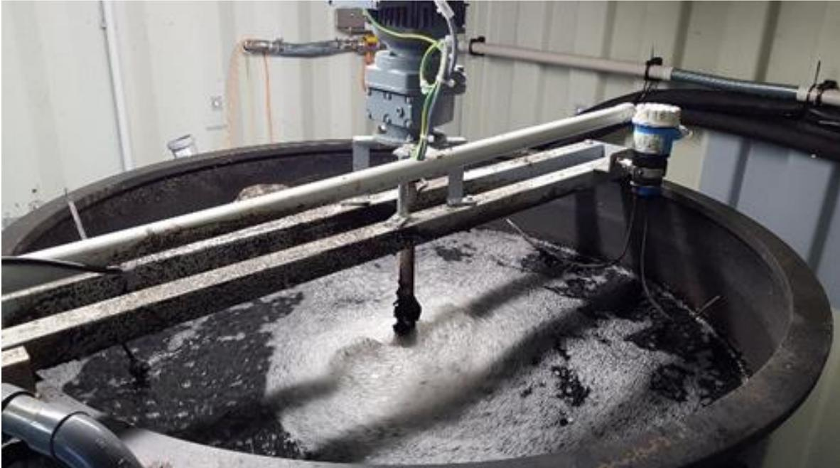
**Abbildung 3-7: MBBR-Becken im Betrieb**
